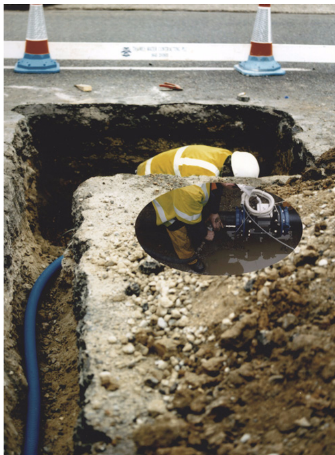
Instalación subterránea del MagMaster
