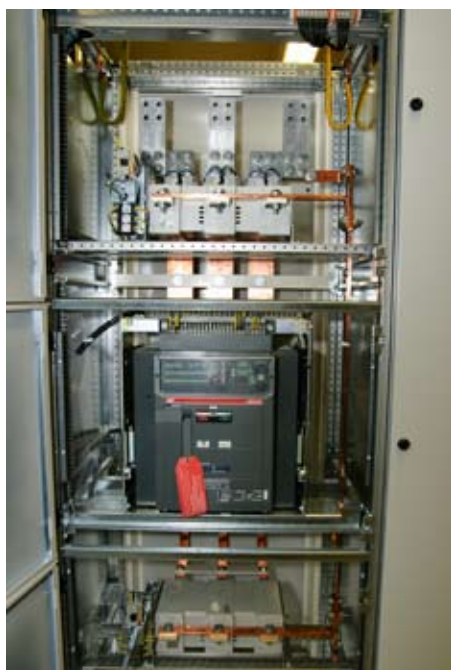
Emax sērijas 3200A automātiskais gaisa jaudas slēdzis ar diviem zemēšanas slēdžiem.
