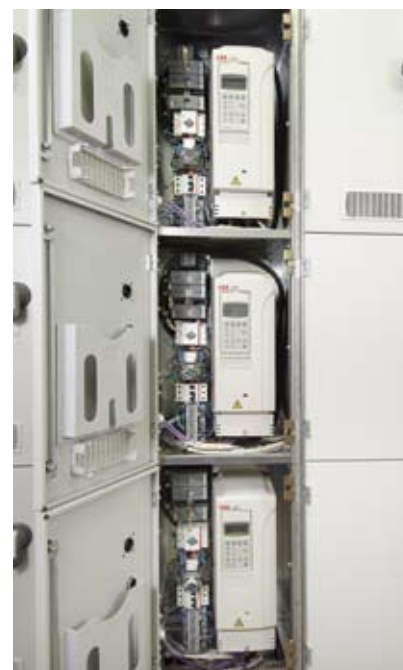
Frekvences pārveidotāji integrēti MNS sistēmā.
