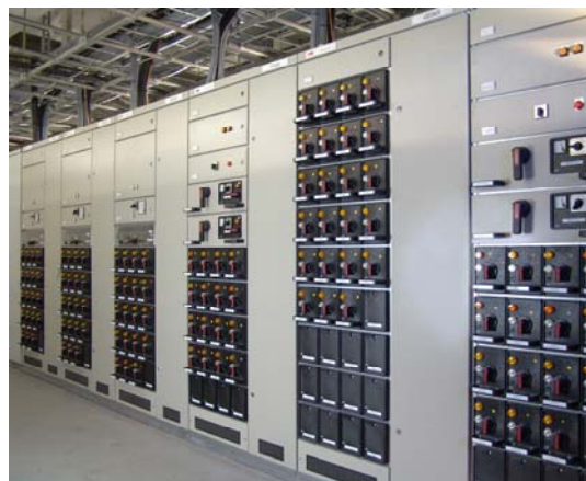
LV switchgear
