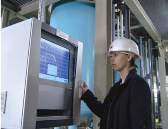
Vor-Ort-Steuerstelle in der Kondensat-Reinigungs-Anlage
