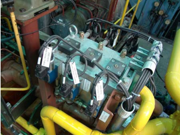
2-von-3 – Auslöseblock mit SIL3-Zertifizierung
