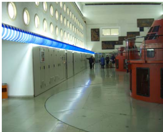
Turbinenhalle nach Abschluss der Modernisierung
