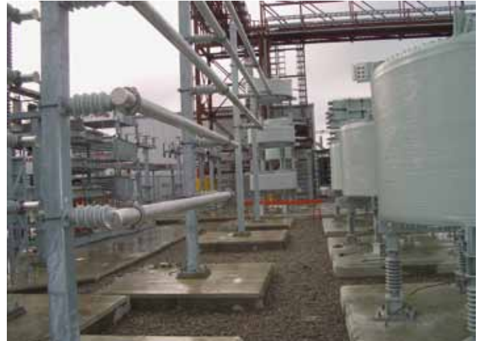
Fig. 1: Gerdau AmeriSteel SVC.
