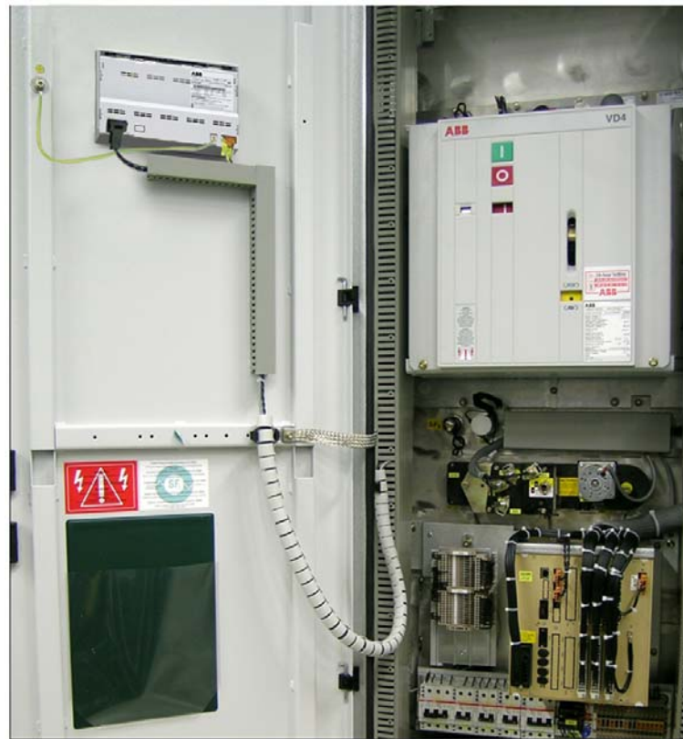
Abb. 3.-3 Montage der Zentraleinheit im NS-Schrank und des HMI in der Schranktür
