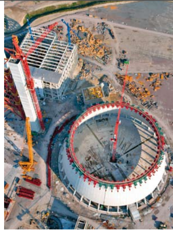
In Datteln entsteht das weltweit grösste Umrichterwerk für die Deutsche Bahn.
