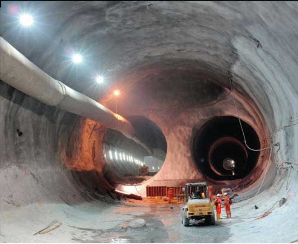
Am 1. August 2009 waren von den insgesamt 151,84 km Tunnel, Schächte und Stollen des Gotthard-Basistunnels bereits 136,6 km oder 90 % ausgebrochen.
